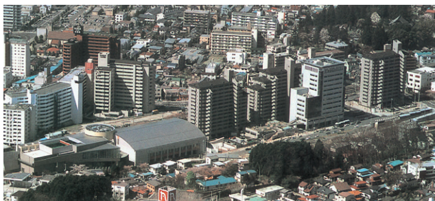
北仙台駅第一地区
