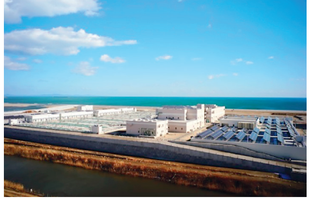
災害復旧工事が完了した南蒲生浄化センター
