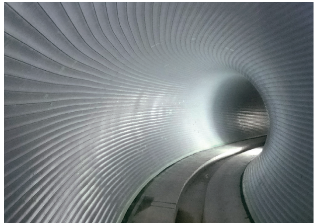
浸水対策のための地蔵前雨水幹線
