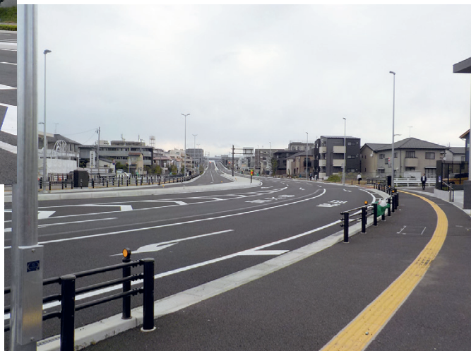
宮沢根白石線(舟丁工区)
