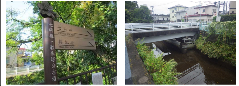
鞍配堀取入ゲート
