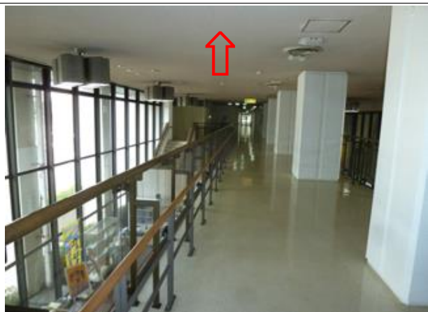
エントランスホール吹抜 2階天井
