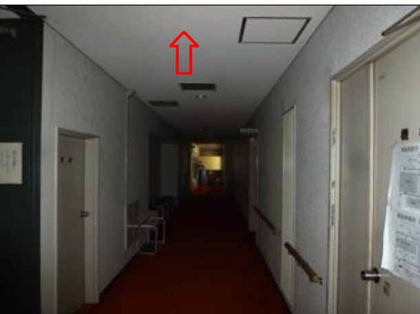
研修棟2階廊下天井
