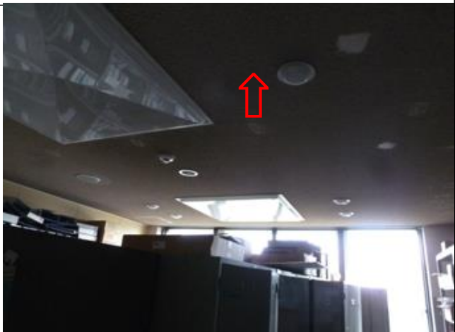
撮影場所: 3階EV前資料室 撮影日時: 2016年8月
