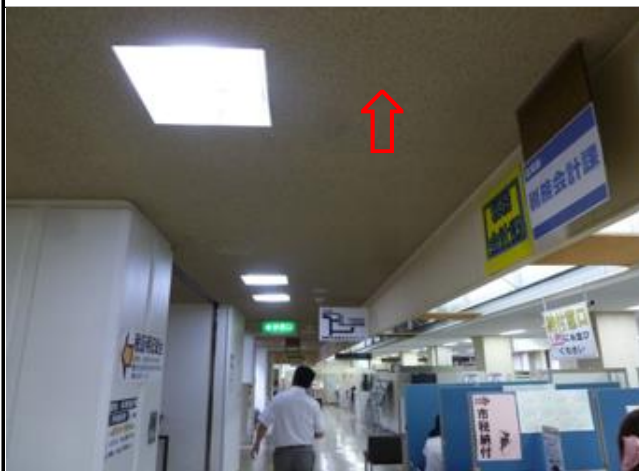
撮影場所: 2階ロビー、廊下 撮影日時: 2016年8月
