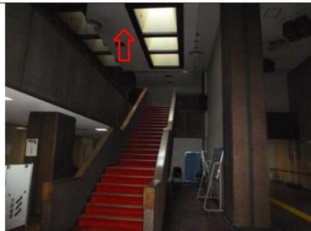
研修棟1階ロビー天井
