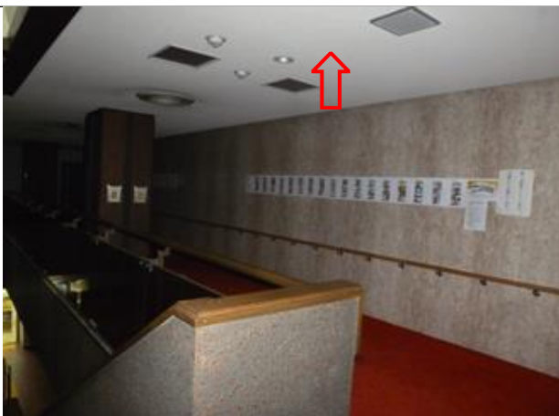
研修棟2階ロビー天井
