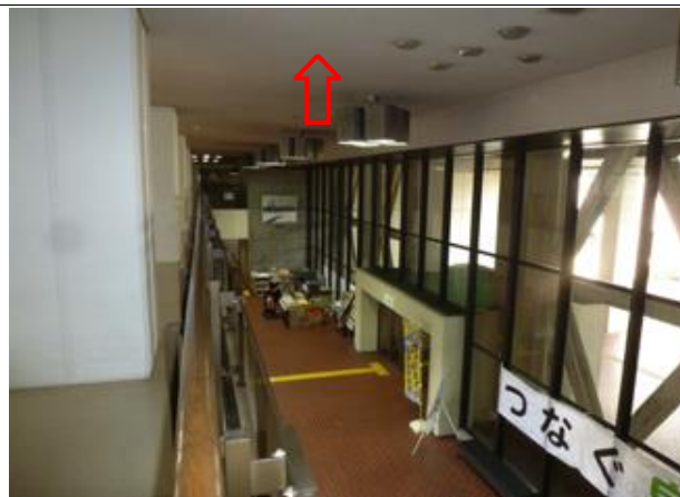
エントランスホール吹抜 2階天井
