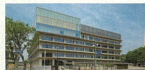
庁舎施工実績
