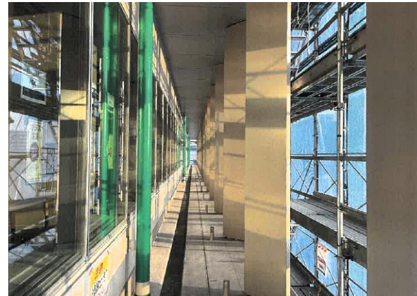
▲外装ルーバー
