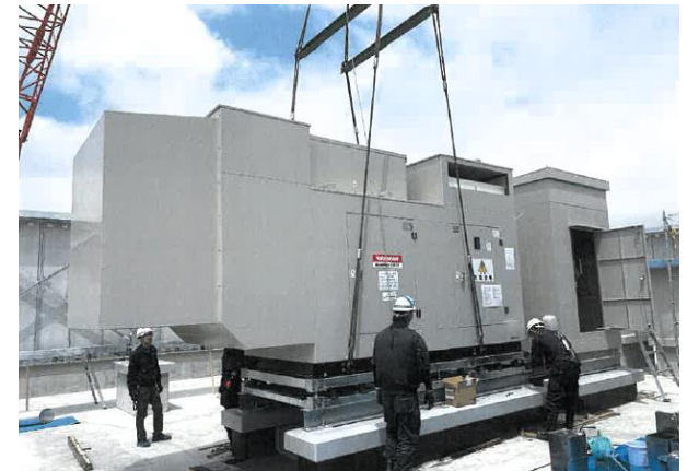
▲非常用発電機
