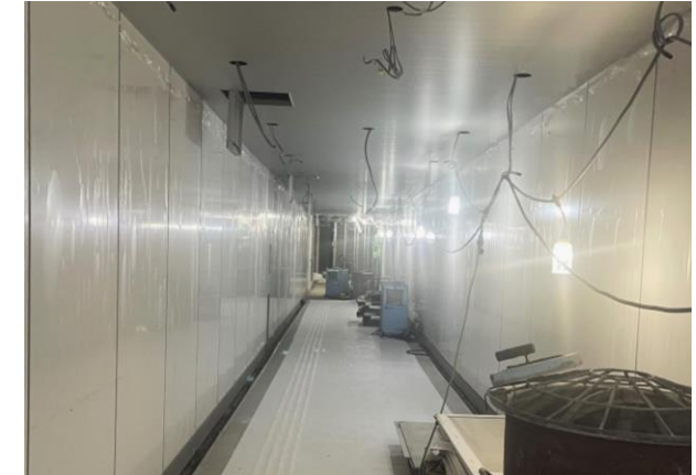
▲地下連絡通路
