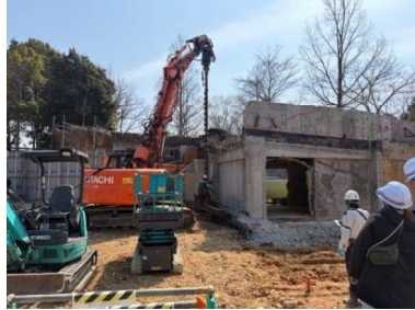
← 親杭作業中 （穴あけ）
