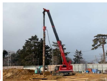
← 杭抜き用の重機
