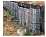
仮囲い（平原動物舎裏側）
