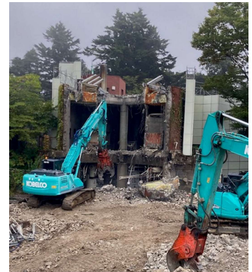
解体用重機を使用し、旧ゴリラ舎側から解体を始めていきます。
